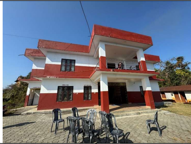
वडा कार्यालय भवन
